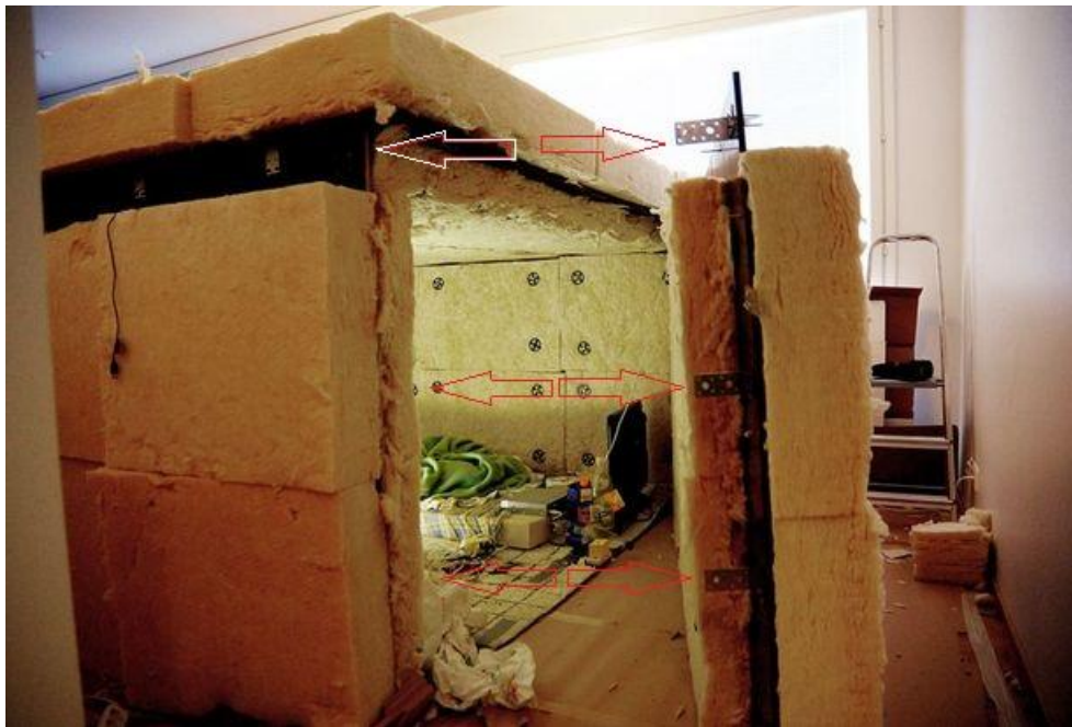
Sieppauskopin oven kiinnittäminen naulauskulmalla
